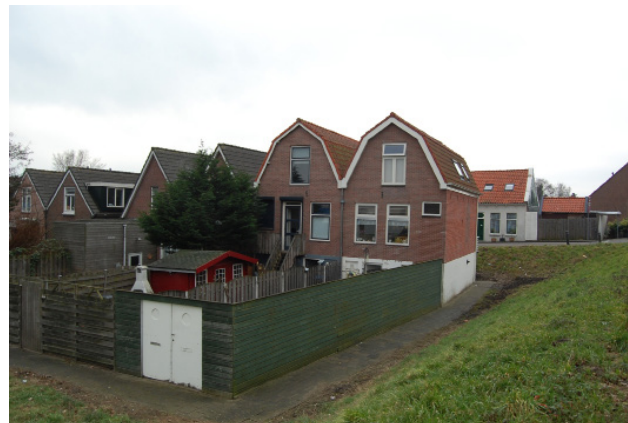
Adriaan Roggestraat: achtererven aan dijk
