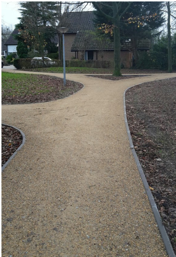
halfverharding voor de paden met opsluitbandje
