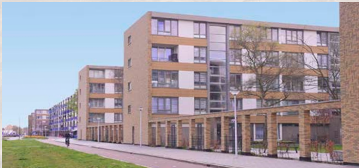
▲ E-FLATS NA RENOVATIE
